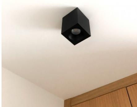
**100% étanches à l'air**, bloquant ainsi le flux d'air entre le faux plafond et la pièce.
